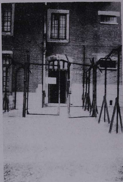
Entrée du Bloc 24.
